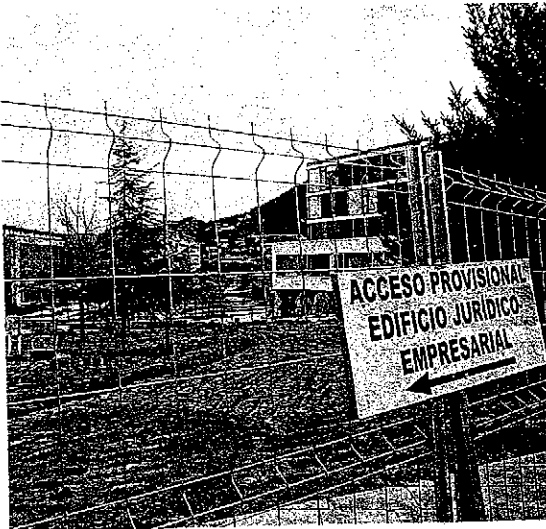
En el campus se están ejecutando actualmente varias obras | MIGUEL VILLAR
